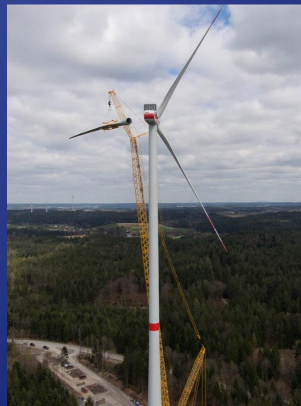
Rotorblattmontage EnBW- Windpark Bühlertann
