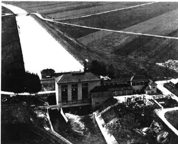
Kraftwerk Illerstufe III Unteropfingen.
