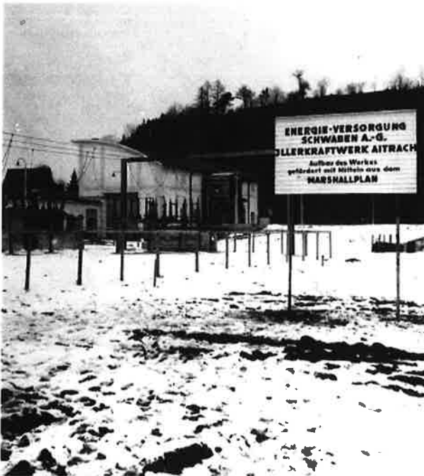
Das ehemalige Umspannwerk beim Illerkraftwerk Aitrach mit Hinweistafel auf Förderung aus dem Marshallplan.
